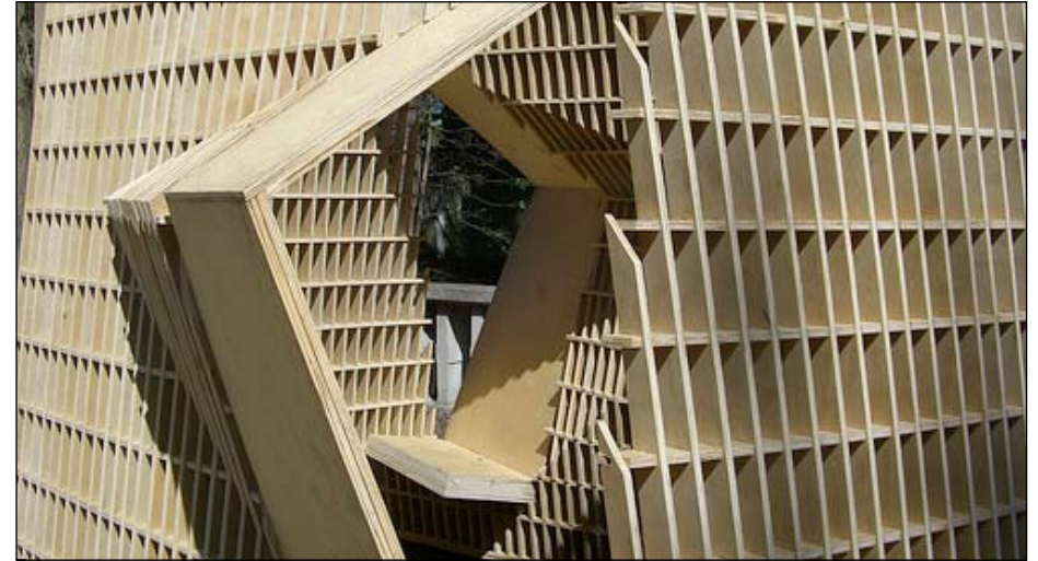
Estructuras en escala 1:1. Fresadora 3 Ejes en chapa de madera (Sustractiva). Fuente: wompuscat at flickr
